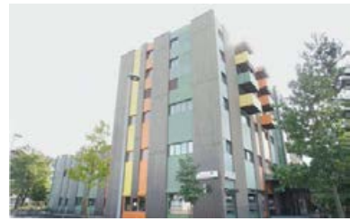
18. Delémont, Rue de l'Avenir 3/5
