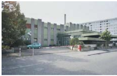
17. Delémont, Rue de l'Avenir 1
