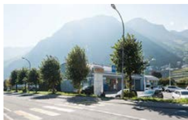
83. Vouvry, Chemin du Grand-Clos 1
