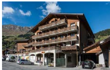
41. Les Diablerets, Avenue de la Gare 2
