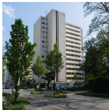
81. Spreitenbach ZH, Bahnhofstrasse 61
