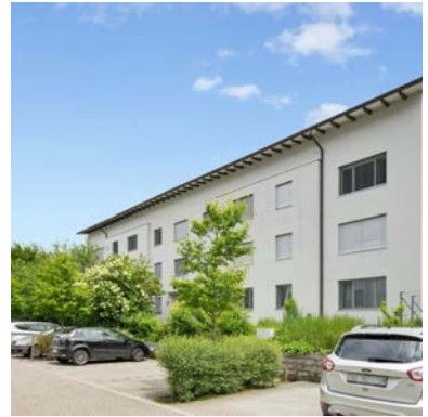
60. Oftringen AG, Gilamstrasse 21
