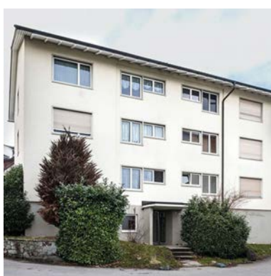
74. Richterswil ZH, Zugerstrasse 28-36
