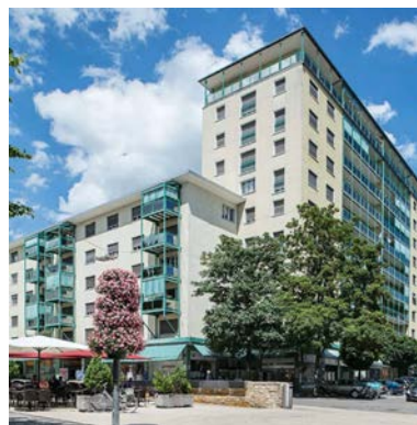
33. Grenchen SO, Marktstrasse 1/3, Marktplatz 14/16
