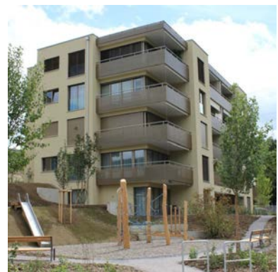
42. Lausen BL, Furlenbodenstrasse 1/3, Furlenstrasse 37
