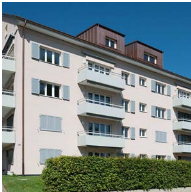
64. Opfikon ZH, Oberhauserstrasse 12
