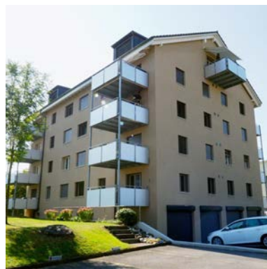
57. Oberentfelden AG, Sonnenhofweg 4
