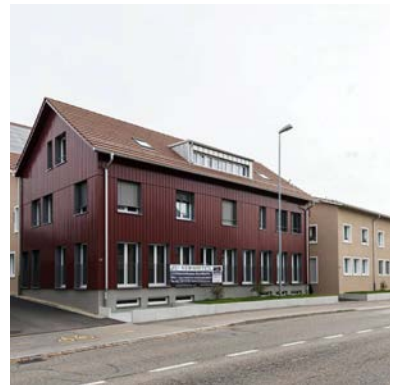
66. Pfäffikon ZH, Hochstrasse 137/139/141, Langackerstrasse 8/10
