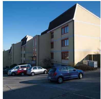
36. Laufen BL, Grienweg 3/5/7
