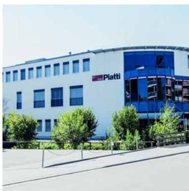
107. Dietlikon ZH, Riedmühlestrasse 12/16/18
