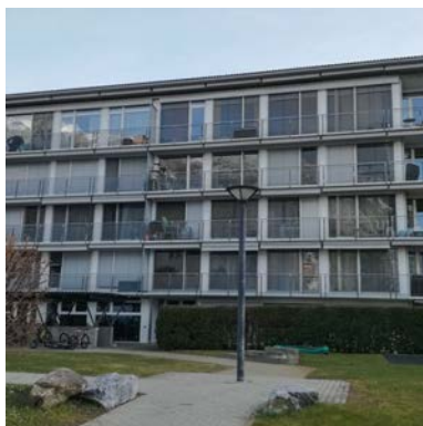
19. Chur GR, Ringstrasse 205, Saluferstrasse 12
