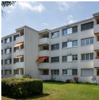
61. Oftringen AG, Staufergutstrasse 2/4
